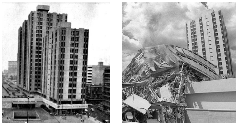
Figura 2.3 Conjunto Urbano Pino Suárez, Ciudad de México. Conjunto de 5 edificios (dos de 13 pisos y tres torres centrales de 20 pisos). Durante el terremoto una de las torres se desplomó por completo, el resto fueron demolidas en 1987 debido a que sufrieron daños importantes
