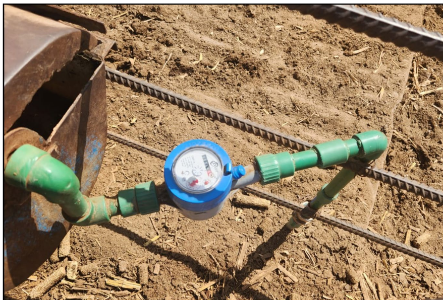
Figura 20. Medidor de agua ubicado en el tubo de alimentación del bebedero.
