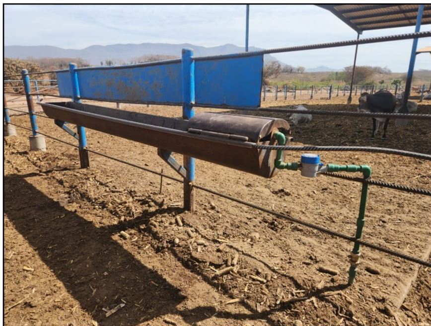
Figura 19. Bebedero equipado con medidor de agua de flujo continuo.
