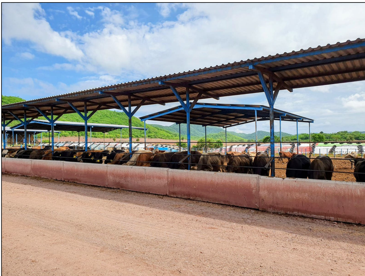
Figura 11. Comederos lineales tipo canoa de concreto.
